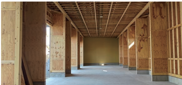
最大スパン約30mの2x4工法トラス
