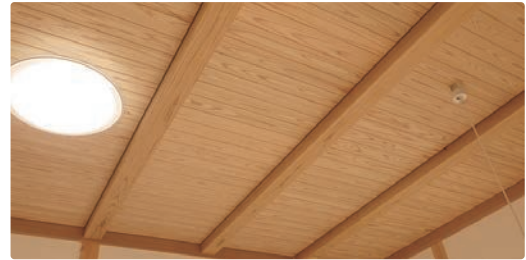
本実加工された無地上小の杉板は壁・天井・軒天にも利用されます
