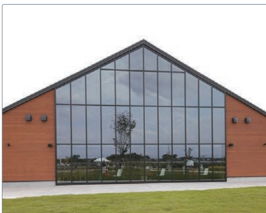
埼玉県深谷市の大型商業施設 外壁全面に厚 30 スギをヨコ張りの上木材保護塗料
