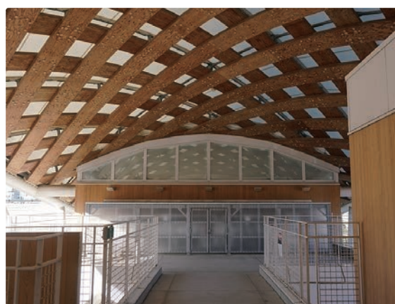
鉄骨リングとLVLを組み合わせた局面屋根の複合施設
