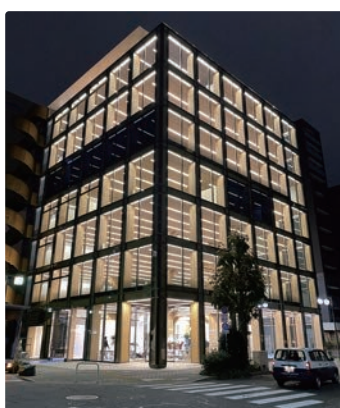
CLTとRCと組み合わせた 地上8階建ての事務所ビル
