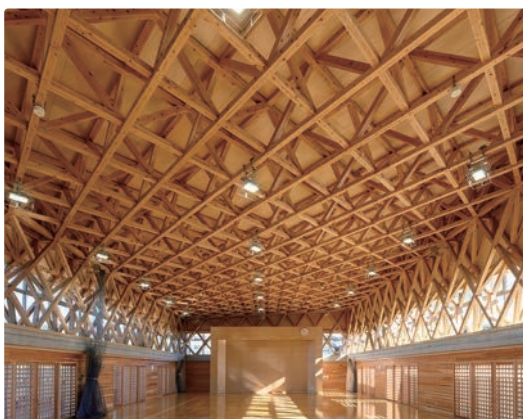
地域のヒノキ・スギの製材のみを使用した木組みの木造空間
