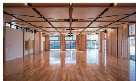
Aパネを耐力壁に採用 天井を高くし大開口で開放的に
