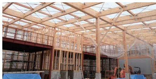
最大スパン 8.8m 一般流通材を継いでコストを最小限に
