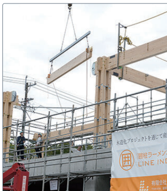
スピード感ある現場施工
