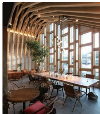
製材を使用した木組のトラス構造
