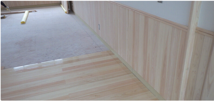
本実加工された桧板は内装材として非住宅にも利用されています
